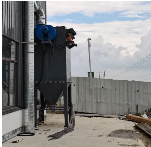
破碎房+集气罩+布袋除尘器
