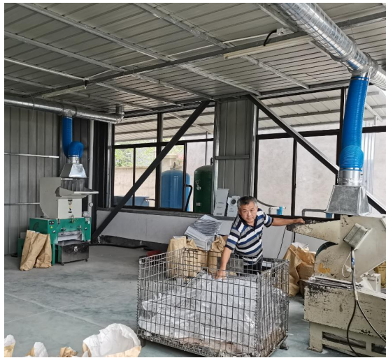
破碎房+集气罩+布袋除尘器
