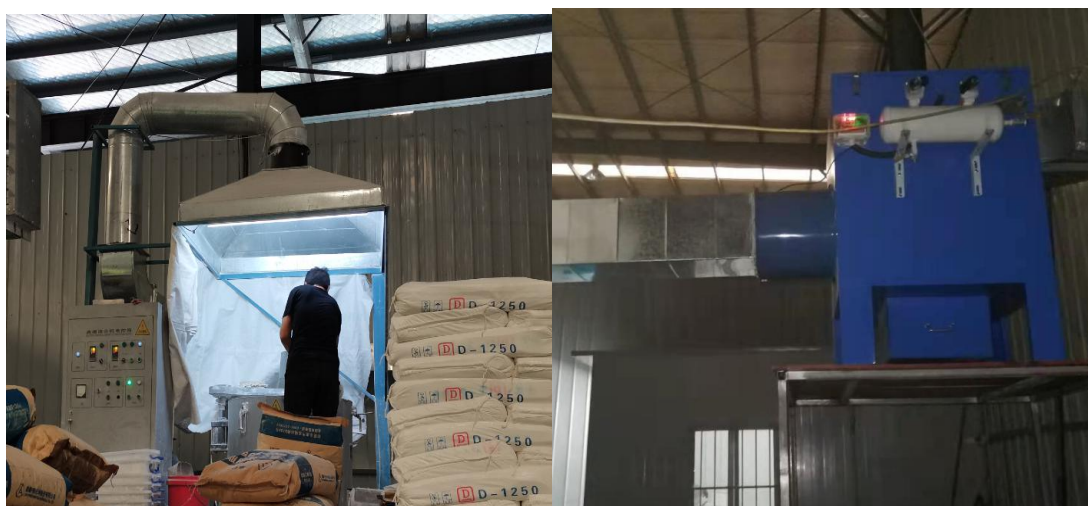
投料拌料粉尘:集气罩+布袋除尘器+15m 高排气筒
