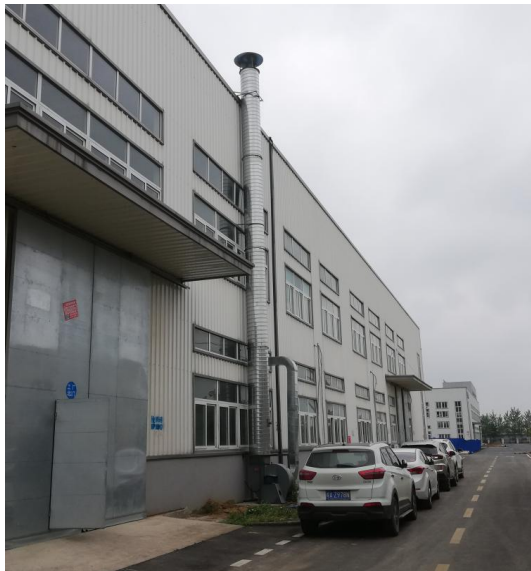
有机废气收集系统及有组织排放
